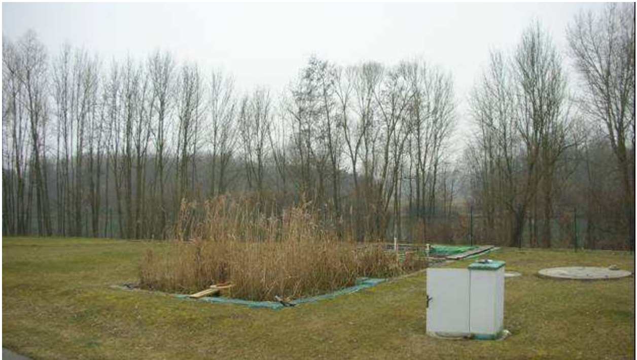
Abbildung 74: Versuchsanlage am 13. Februar 2008
