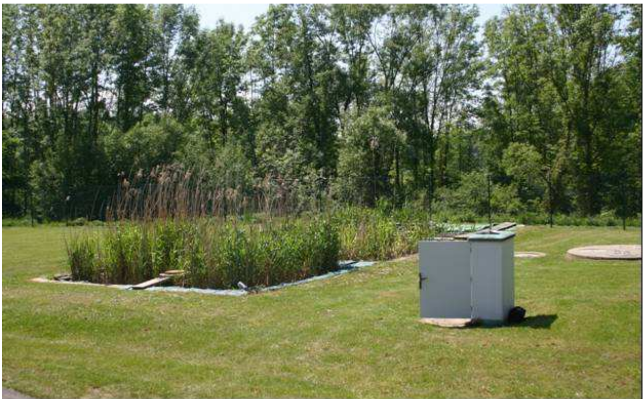
Abbildung 76: Versuchsanlage am 15. Mai 2008
