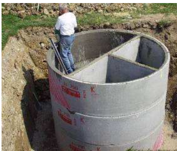
Abbildung 5: Errichtung der 3-Kammer-Absetzanlage
