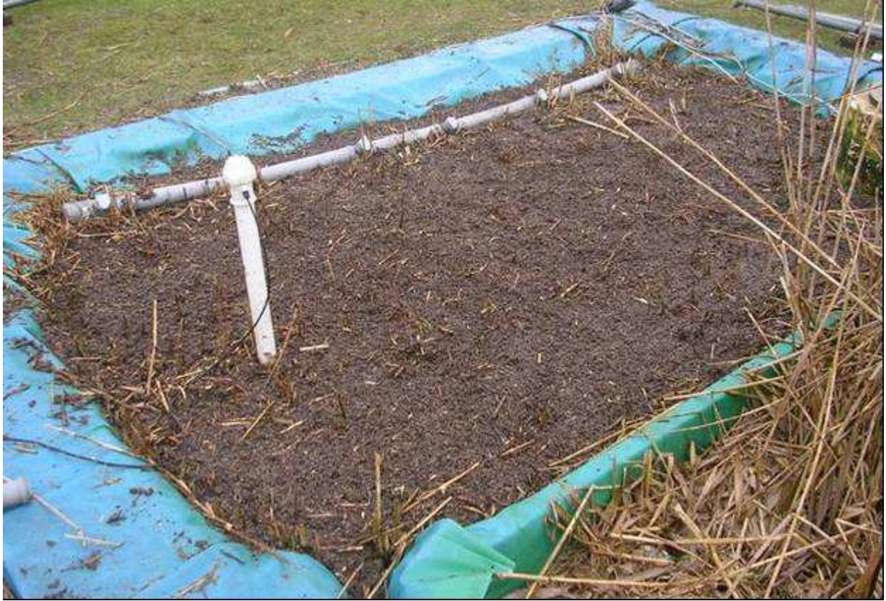
Abbildung 87: Bodenfilter BF3 am 25. März 2009, nach der Reinigung der Oberfläche von BF3.1
