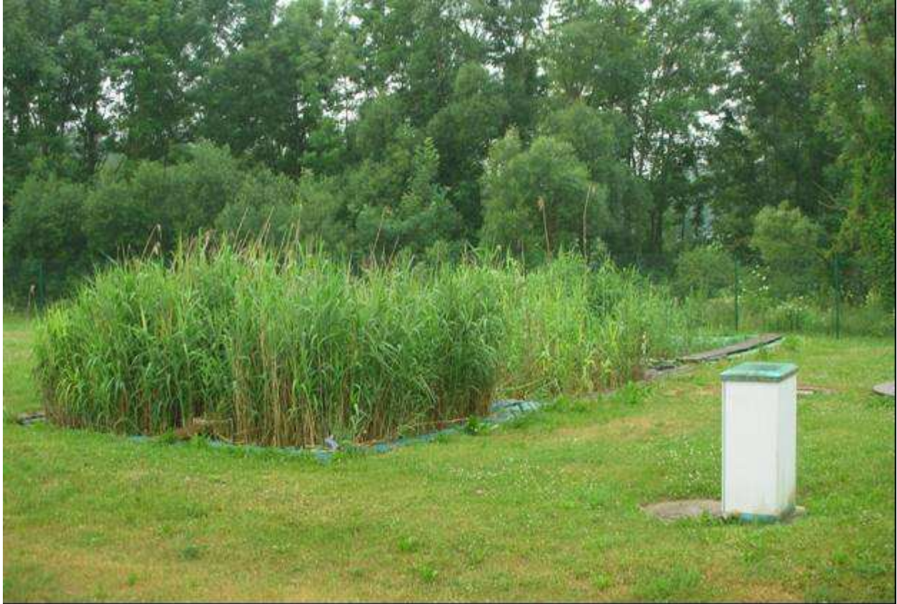
Abbildung 77: Versuchsanlage am 4. Juni 2008
