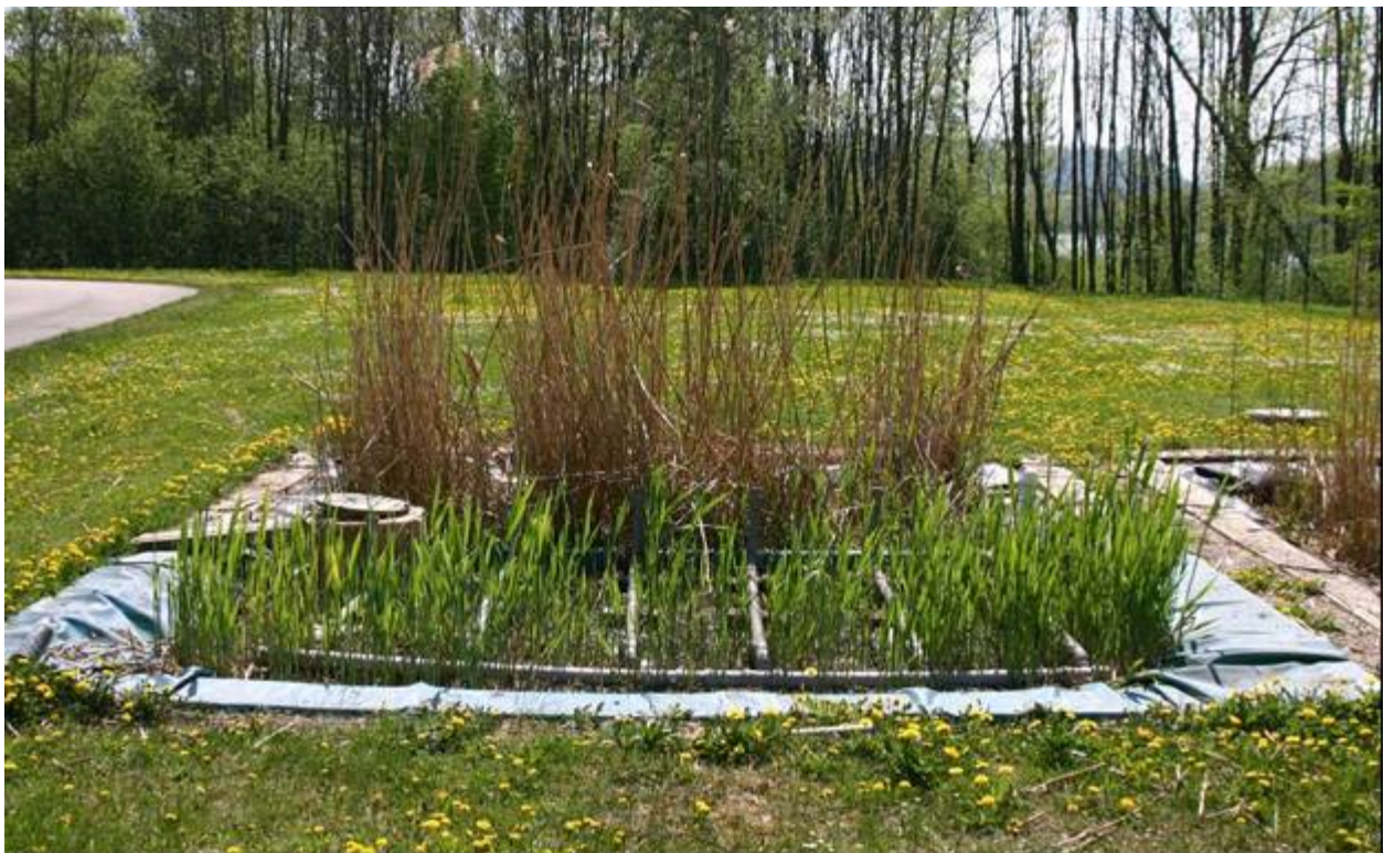
Abbildung 90: Bodenfilter BF3 am 20. April 2009
