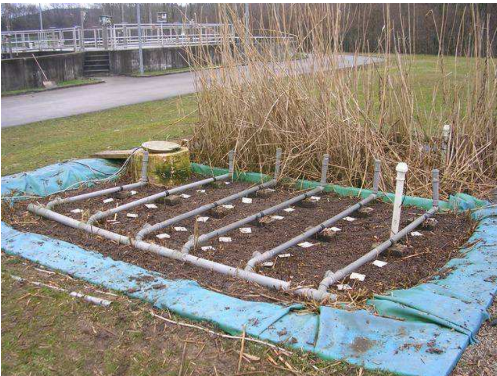
Abbildung 58: Bodenfilter BF3.1 nach Begradigung der Oberfläche am 26.3.2009.
